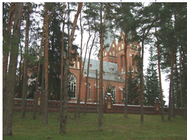
31. attēls. Viļakas katoļu baznīca
