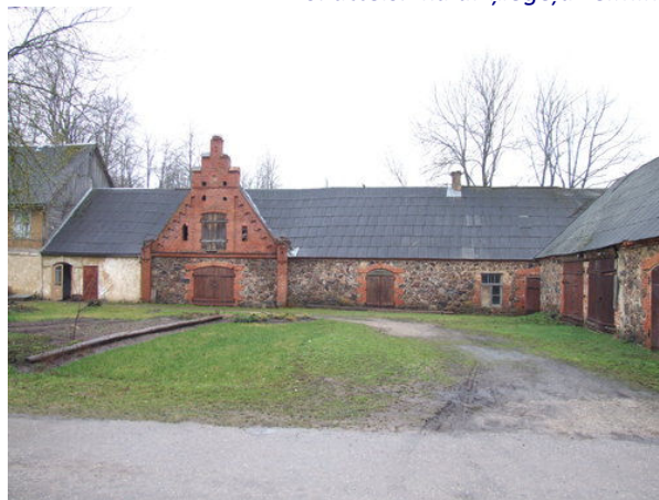
26. attēls. Ēka ar ķieģeļu zelmini
